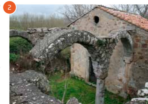
Fig. 3 Chiesa di San Giuliano presso Barbarano Romano, stato di fatto, cortile interno dettaglio arcate e romitorio.
