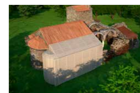
Fig. 13 La chiesa di San Giuliano, un museo nel parco, stato di progetto, vista diurna, ricostruzione della navata laterale e della biglietteria, integrata con la muratura originaria.
