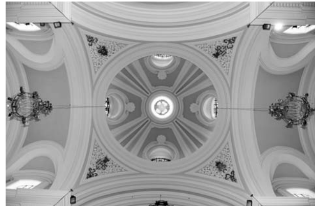
Foto 7 - Veduta della cupola dal transetto.
