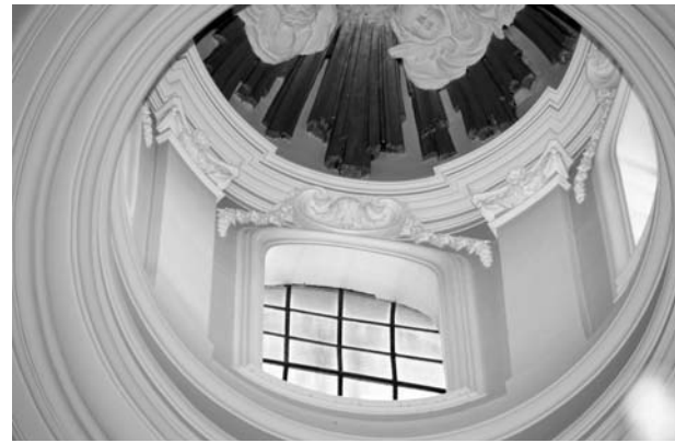
Foto 6 - Le finestre interne del cupolino.
