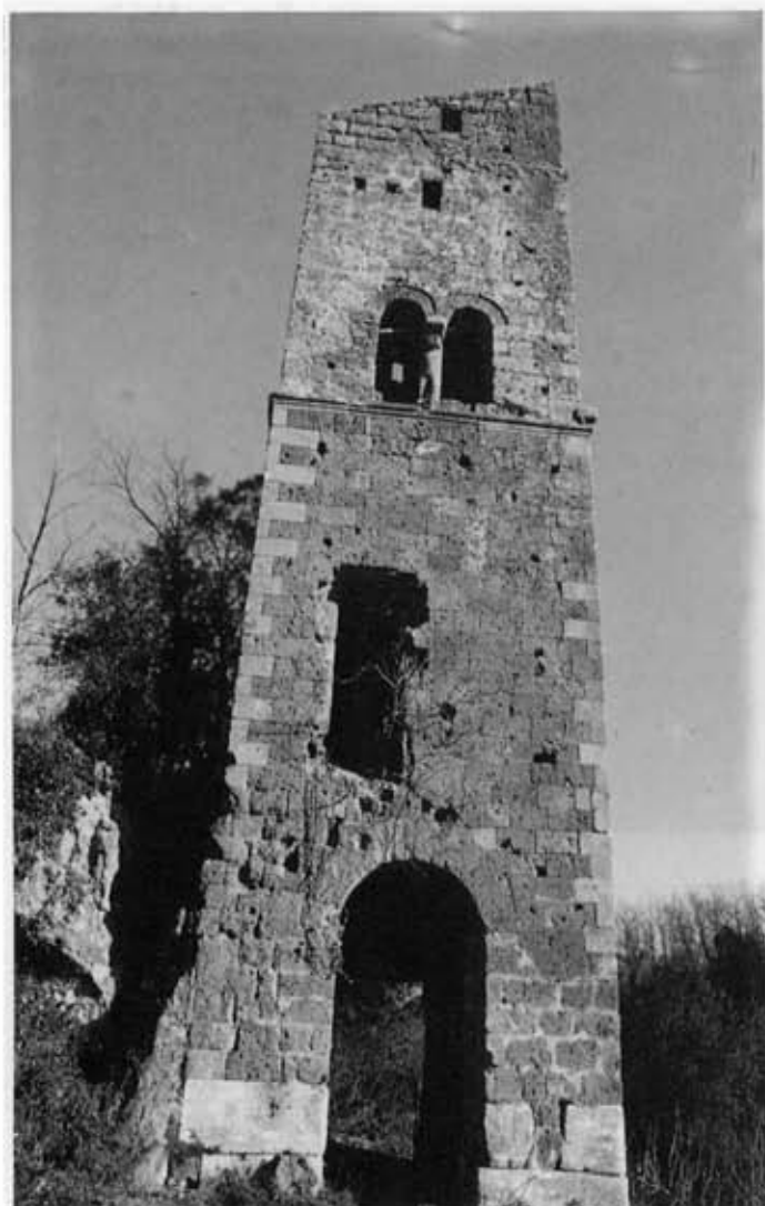
Foto 5 - La torre campanaria. Prospetto ovest, davanti alla chiesa.
