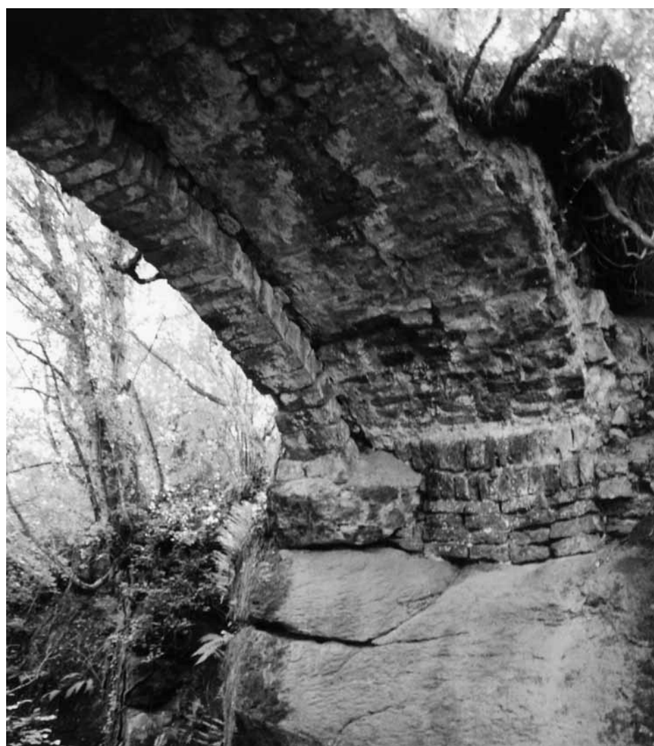
Fig. 4. Spalletta sud del ponte.
