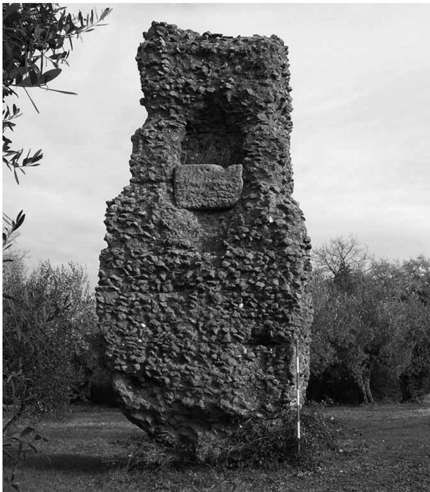
Fig. 7. Lato ovest del monumento funerario.
