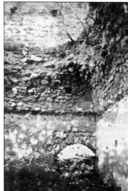
Fig. 27 - Una delle volte crollate al pianoterra del Casino del Barco di Caprarola.
