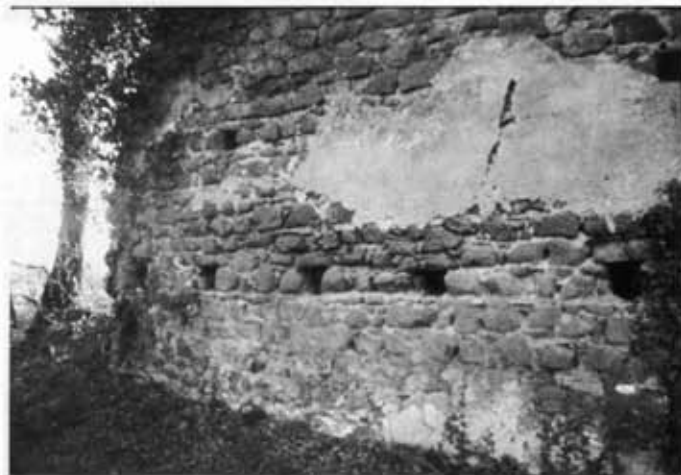
Fig. 24 - Particolare del muro esterno con i fori per il ponteggio di costruzione.
