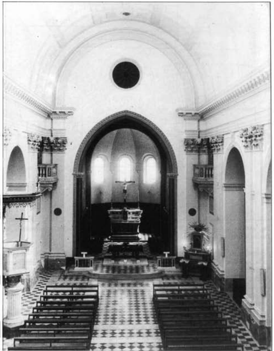
Fig. 4 - Interno del Duomo di Tarquinia.
