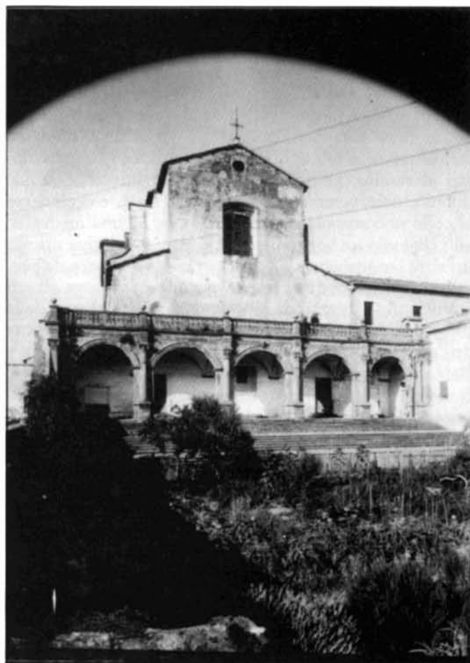
La facciata ed il portico di S. Maria in Gradi
